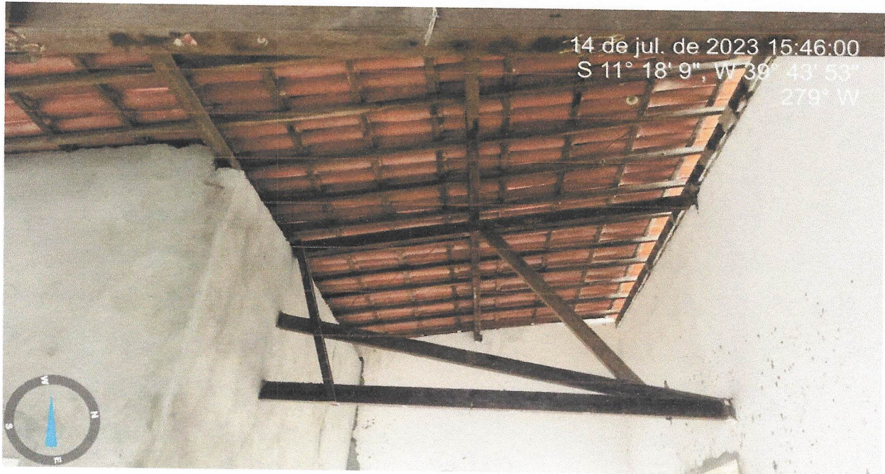
Foto 05 – TELHAMENTO COM TELHA CERÂMICA DE ENCAIXE, TIPO ROMANA, COM ATÉ 2 ÁGUAS, INCLUSO TRANSPORTE VERTICAL. AF_07/2019
