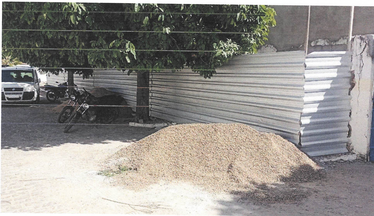
Foto 03 - TAPUME COM TELHA METÁLICA.
