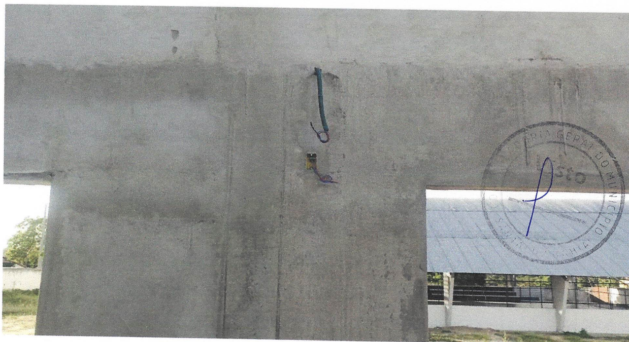
Foto 18 - CABO DE COBRE FLEXÍVEL ISOLADO, 4 MM 2 , ANTI-CHAMA 450/750 V, PARA CIRCUITOS TERMINAIS - FORNECIMENTO E INSTALAÇÃO. AF_12/2015
