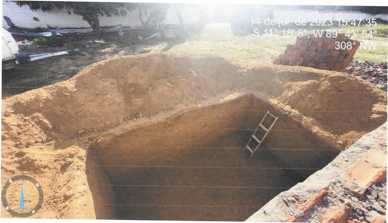
Foto 11- Instalação de sumidouro, fossa séptica e filtro anaeróbio
