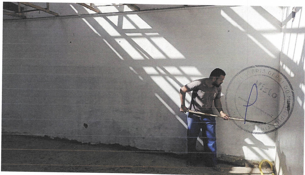
Foto 14 – Preparo de superfície com lixamento de paredes e tetos
