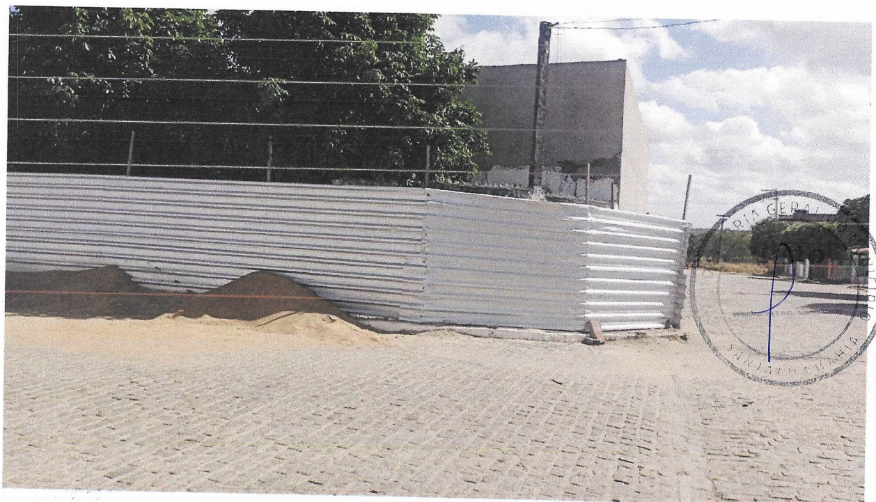
Foto 02 - TAPUME COM TELHA METÁLICA.
