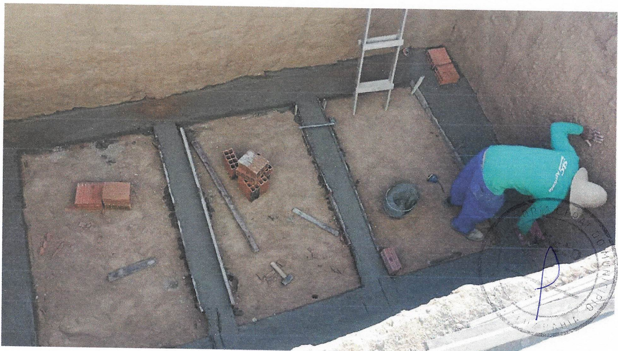
Foto 12 - Instalação de sumidouro, fossa séptica e filtro anaeróbio
