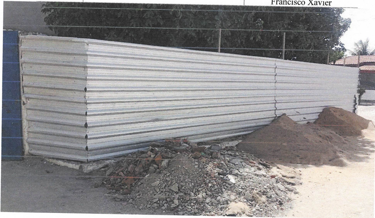
Foto 01 - TAPUME COM TELHA METÁLICA.
