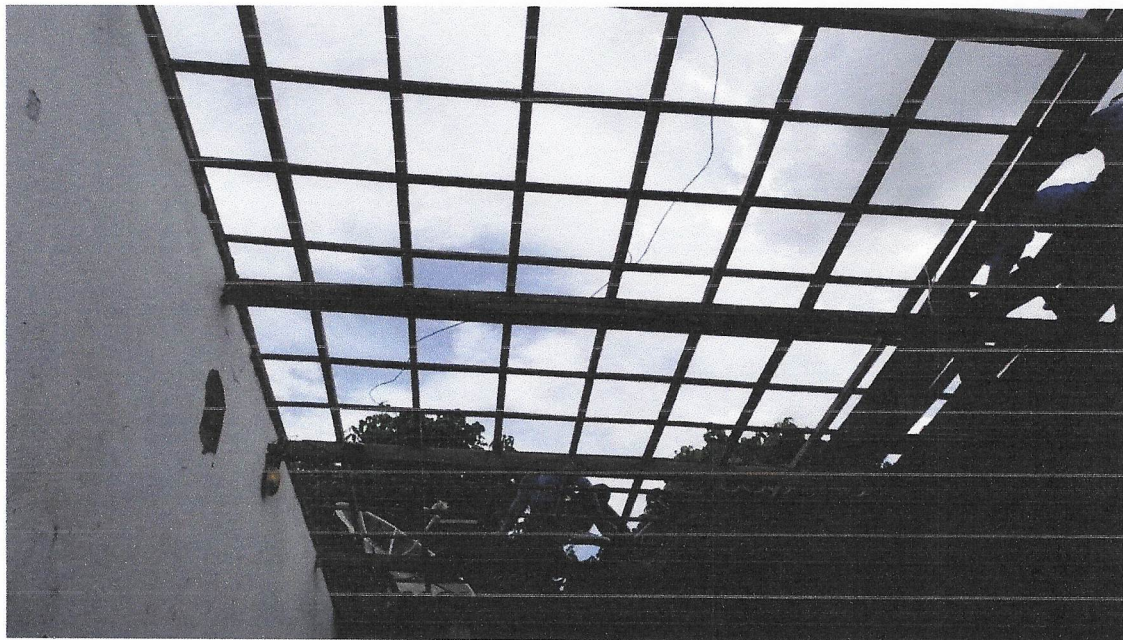
Foto 09- Revisão em cobertura com telha cerâmica tipo canal comum, Itabaiana ou similar, com reposição de 20% do material
