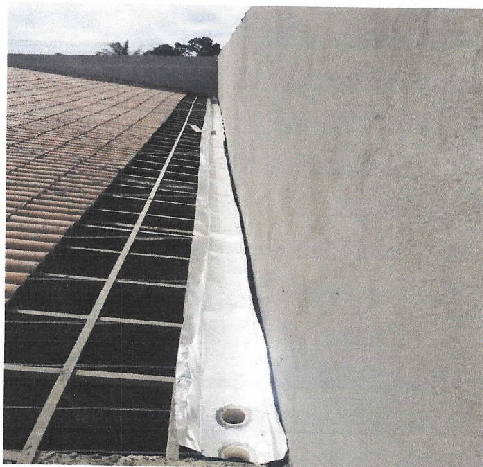
Foto 08- Calha em chapa de aço galvanizado nº 26, desenvolvimento 86 cm (fundo=32 cm, laterais=15 cm, bordas=12cm)
