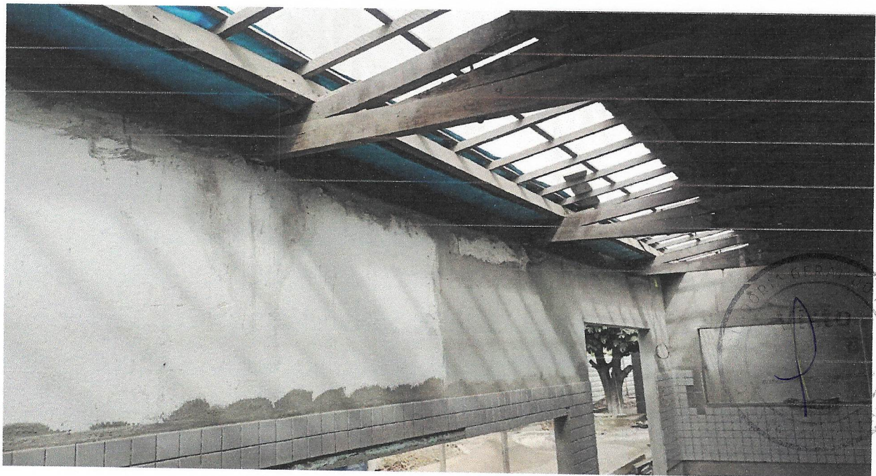
Foto 06- RUFO EM CHAPA DE AÇO GALVANIZADO NÚMERO 24, CORTE DE 25 CM, INCLUSO TRANSPORTE VERTICAL. AF_07/2019
